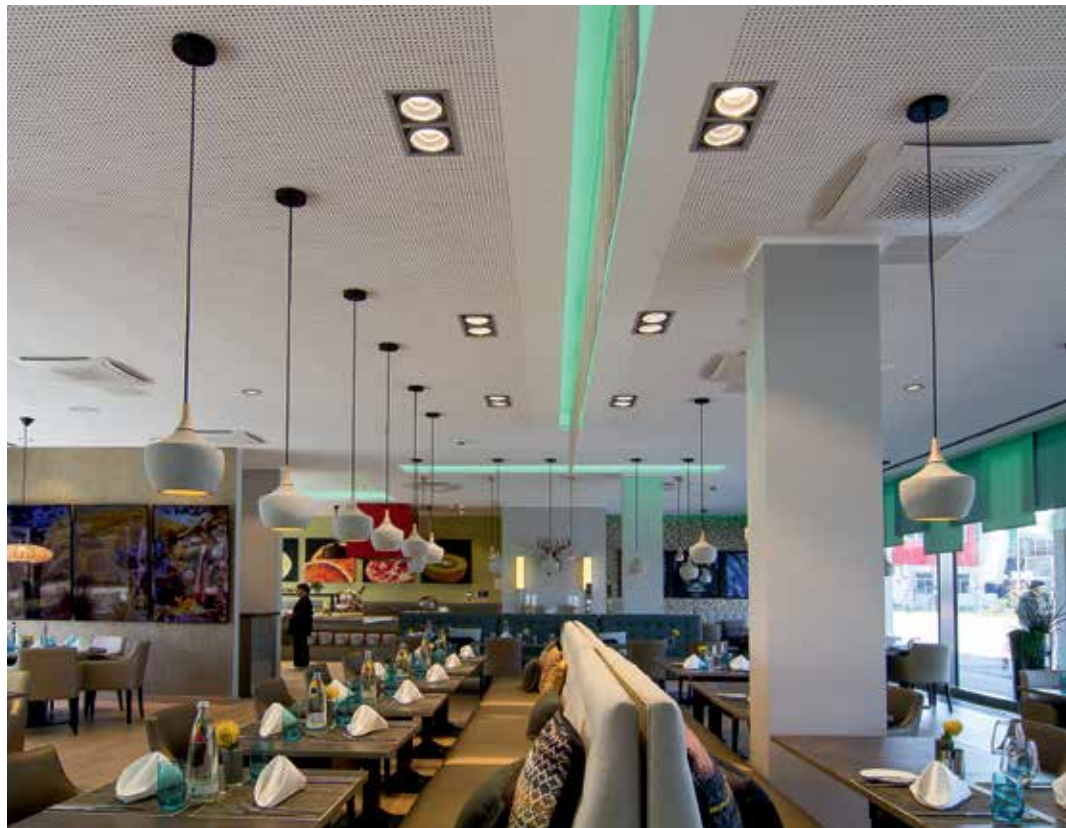
Abb.: LED-Einbaudownlights mit geringer Einbautiefe, Mikroprismenscheibe und warmweißer Lichtfarbe sind für die geforderte Beleuchtungsstärke im gesamten Hotel verantwortlich.
